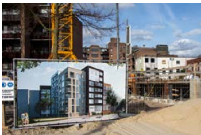
Appartementencomplex de Bruningmeyer aan de Molenstraat in aanbouw
