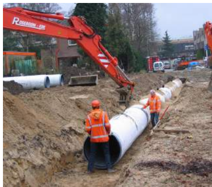
Waterbergende rioolbuis wordt onder de weg aangelegd
