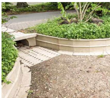
Laag wandje die doelsoorten begeleidt richting de veilige passage onder de weg
