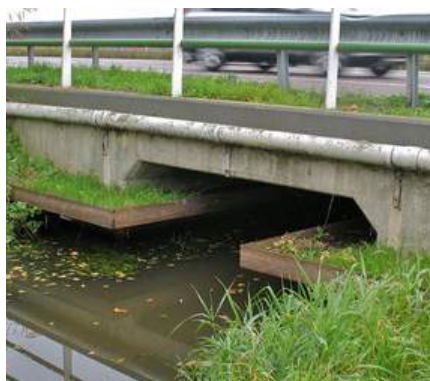
Faunapassage riggel voor kleine zoogdieren en amfibieën - Bron: Bureau Waardenburg B.V.
