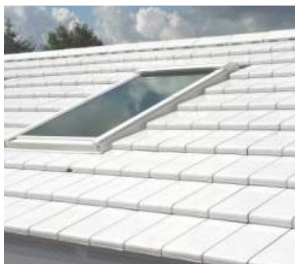
Reflecterend dakoppervlak - Bron: Architectenweb
