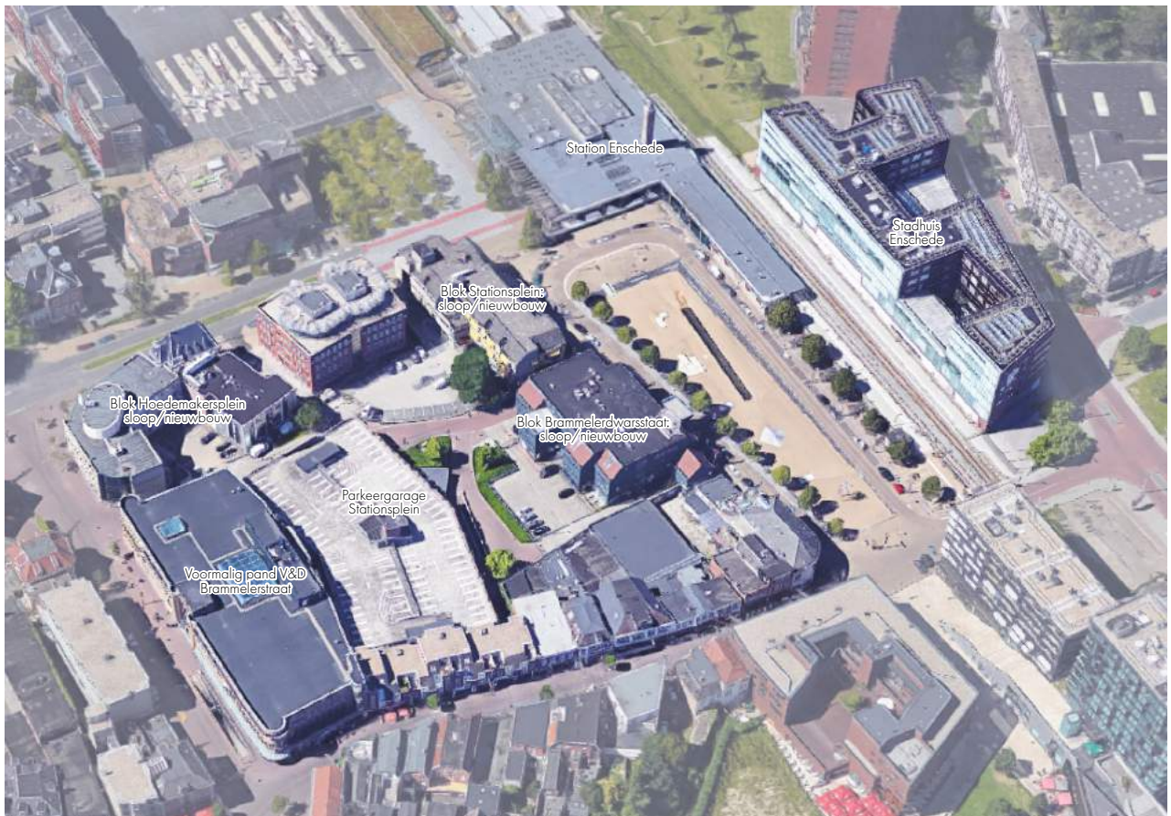
Huidige situatie van het stationskwartier - bron: maps.google.nl
